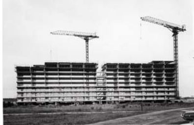
ERA-flats in aanbouw
